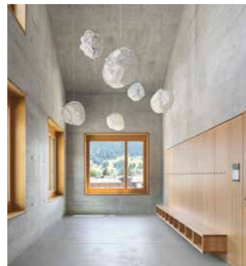
Glatter Sichtbeton mit beispielbaren Akustikholzeinlagen
