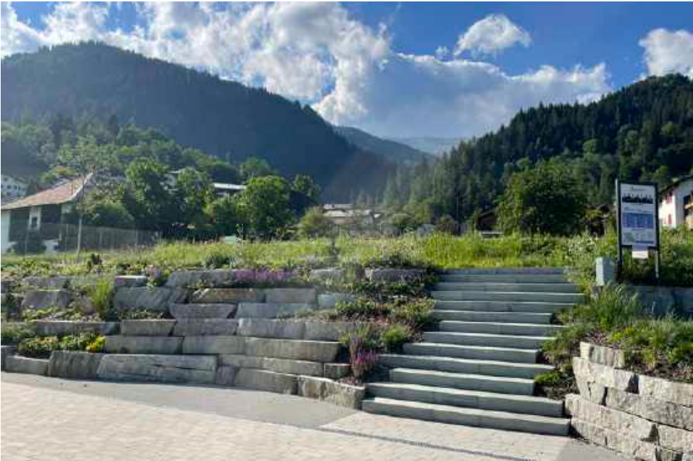
verbindende Elemente: bekletterbare Böschung und Treppen
