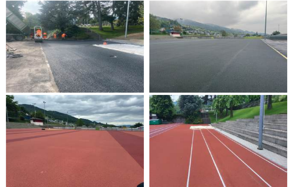
Fortschritt Einbau neuer Belag Laufbahn
