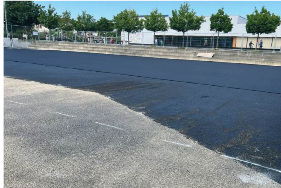
Einbau neuer Belag auf reguliertem Untergrund
