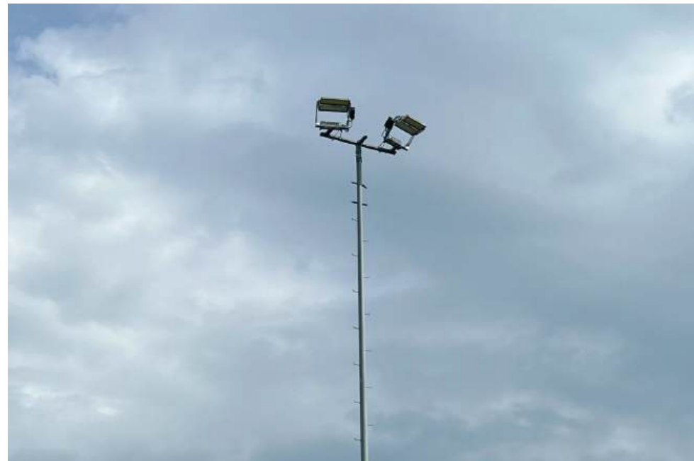
Bestehende Kandelaber mit neuen Leuchtkörpern
