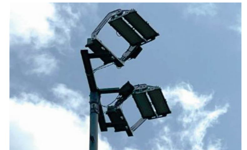
Neue LED-Leuchtkörper nach Montage auf bestehendem Kandelaber
