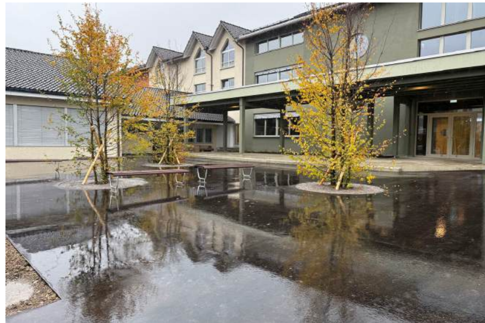
Eingangsbereich mit Bauminseln
